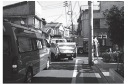
スムーズな消火活動が懸念される不燃化促進用地周辺の状況。右奥の建物の手前が今回取得した不燃化促進用地
